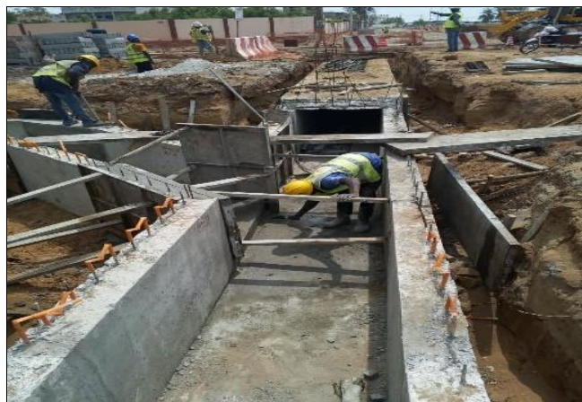
Photo 3: Collecteur en construction dans le Bassin Y
