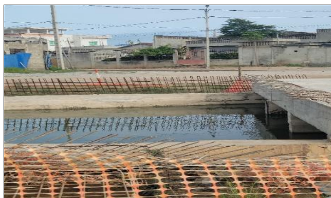
Photo 6: Bassin de rétention en cours de réalisation
