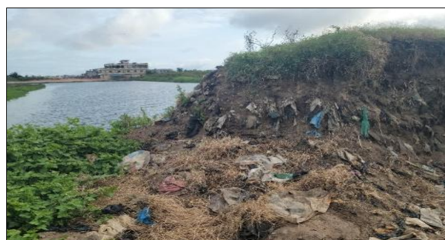
Photo 2: Dépôt de déchets sur un corridor d'écoulement
