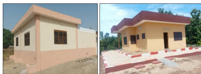
Planche 3: Construction d'une cuisine à la résidence du maire de Ouaké (photo 1) Réception provisoire du logement de l'infirmier au centre de santé de Kassoua (photo 2)
