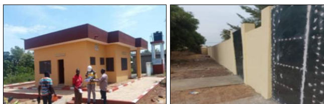
Planche 4: Réception provisoire du logement de la sage-femme de la maternité de Kassoua (photo 1) Fourniture et pose du portail à la résidence du Maire (photo 2)
